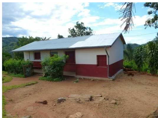
Figure 19- Dispensaire après travaux
