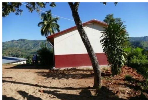
Figure - 25 Dispensaire – Pignon de la partie construite
