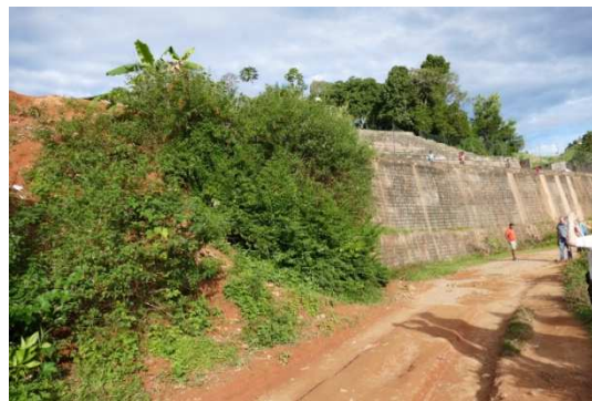
Figure 12 - Mur terre éboulé suite au cyclone dans le prolongement du mur de soutènement
