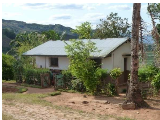
Figure 18 - Dispensaire avant travaux
